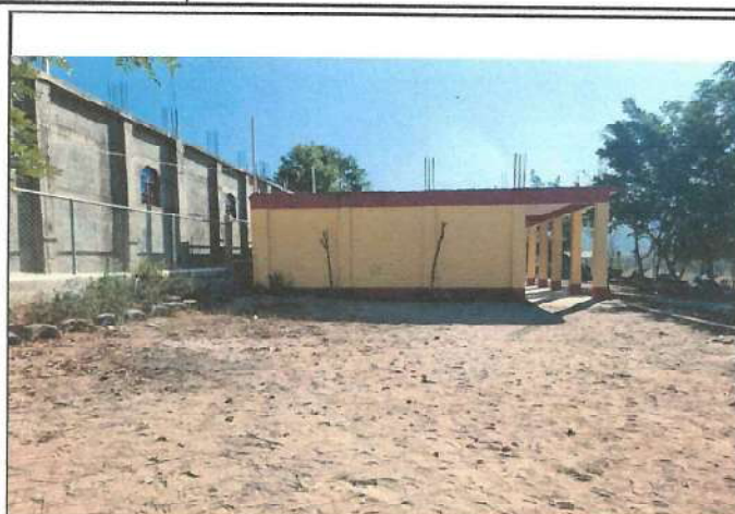
Foto 2: Área de mejoramiento de servicios sanitarios e instalación de área de lavado de manos.
