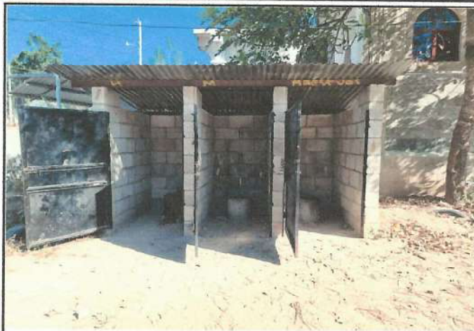
Foto 1: Mejoramiento de los servicios sanitarios
