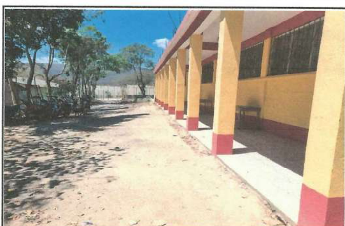
Foto 4: Mejoramiento de losa de patio frente a módulo de aulas.
