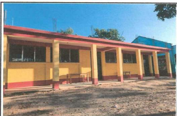
Foto 3: Mejoramiento de losa de patio frente a módulo de aulas.
